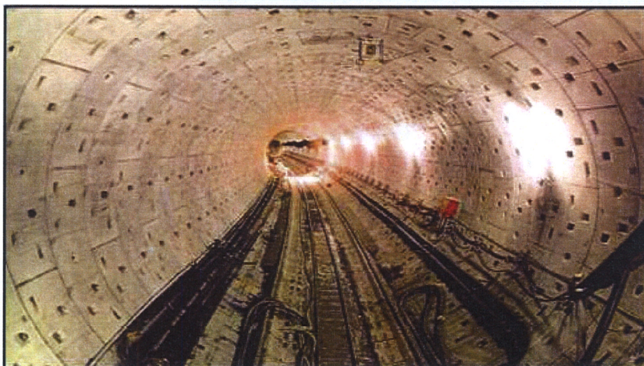
Figura 3.3.2: galleria rivestita con conchi prefabbricati
